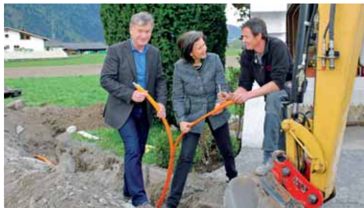
v.l. Bgm. Bernhard Krabacher und LR Patrizia Zoller-Frischauf informieren sich über den Baufortschritt beim Breitbandausbau
